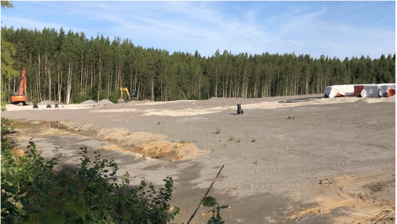
Kuva 6. Vantaa, Sotungin kaatopaikka. Jätetäyttö tasattuna pohjatuhkalla.
