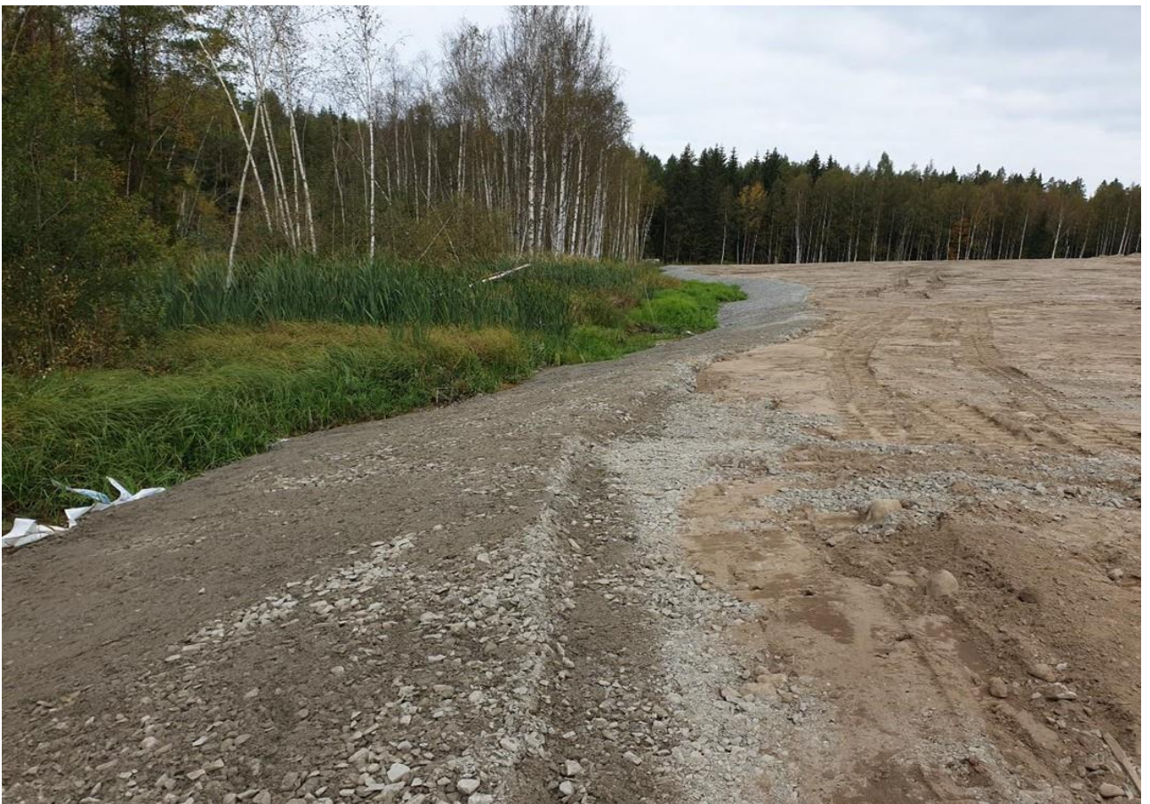
Kuva 7. Vantaa, Sotungin kaatopaikka. Reunapenkereen kalliomurskeverhous ja ylijäämämaa-aineksesta rakennettu pintakerros.
