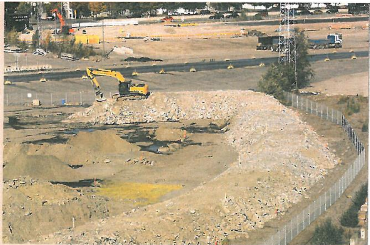
Kuva 1. Hyväntoivonpuiston pilaantuneiden maiden hyötykäyttöalueella rakennetaan reunapenkkaa murskeesta. Kuvan vasemmassa reunassa näkyy hyödynnettäviä pilaantuneita maita aumoilla.
