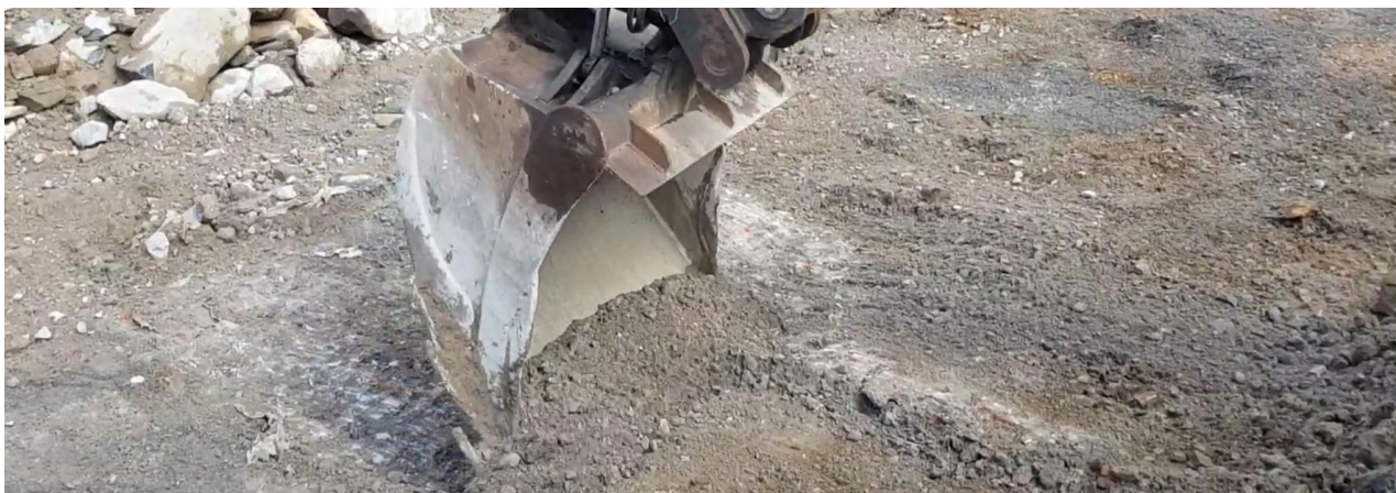
Kuva 1. Vanhan betonimurskekerroksen purkua Putkipolun/Viilarintien alueella toukokuussa 2020.
